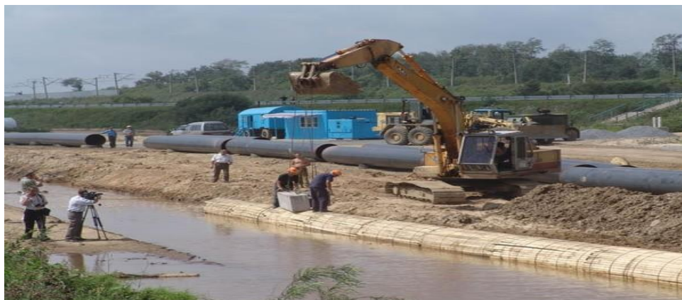
Рисунок 1 - Стройка водозабора на Тунгусском месторождении подземных вод
