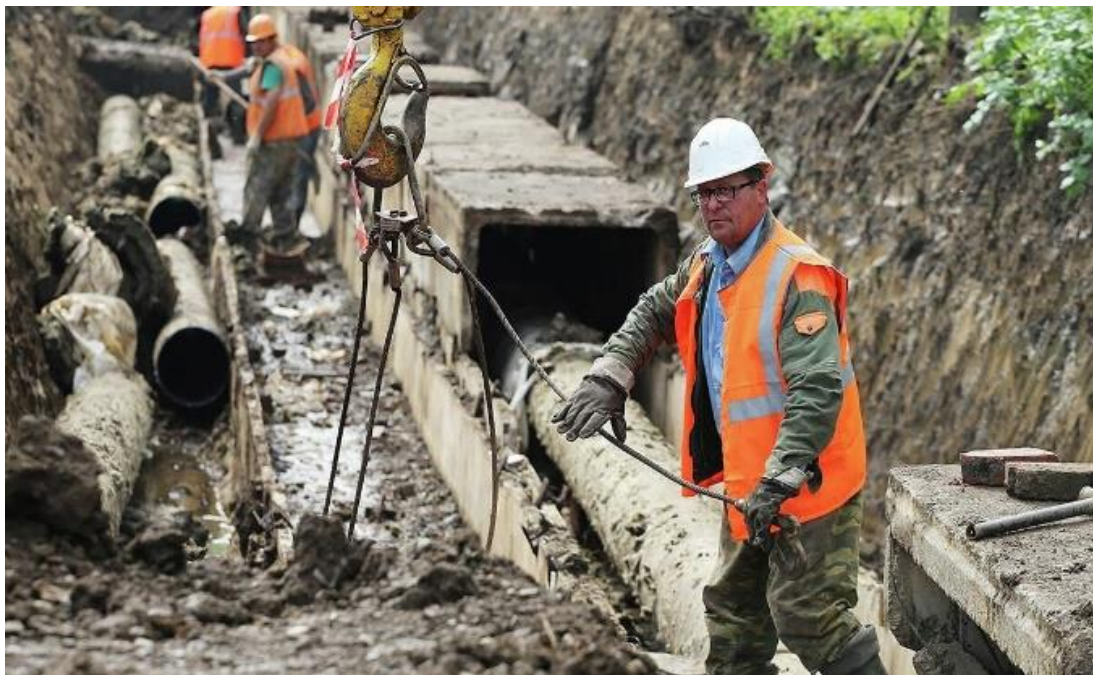
Рисунок 2 – Строительство Тунгусского водозабора
